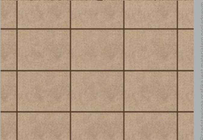
Wykonanie imitacji pyt piaskowca z zastosowaniem ozdobnego tynku typu „PIASKOWIEC” oraz listew do boniowania BP11 MINI S i łączników krzyżowych BP11 MINI MAX CC.
